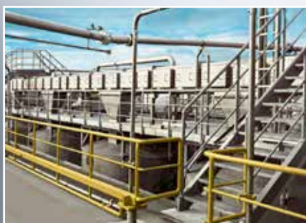
Horizontální plynotěsný kyvný korečkový dopravník
